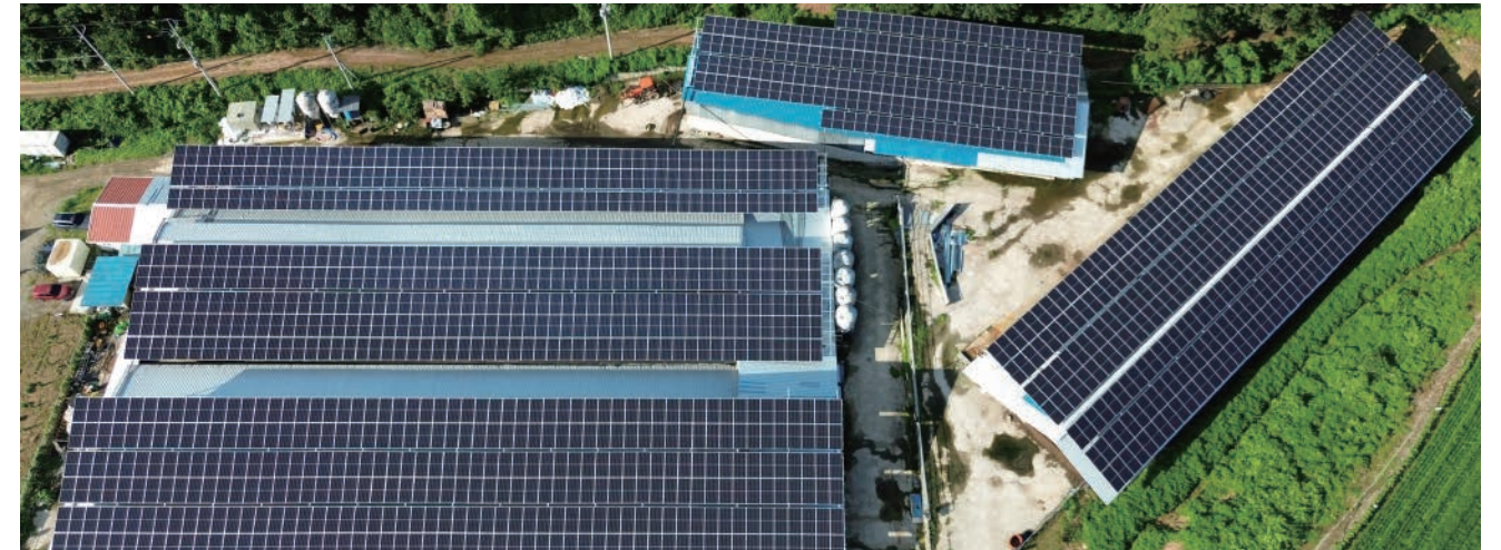
Coréia Data de instalação: 2024
